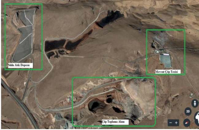
Şekil 8. Kayseri Katı Atık Düzenli Depolama Sahalarında Depo Gazından Elektrik Üretim Tesisinin Görüntüsü
