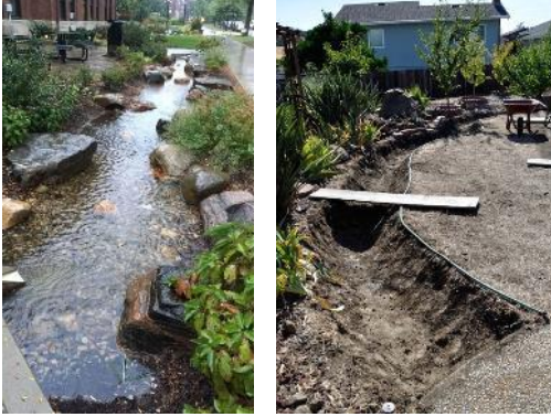
Şekil 1. Tesviye ile drenaj kanallarının hazırlanması URL3,URL4
