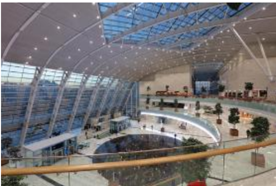
Resim 11. Ankara Tren Garı Çatı ve Bina Strüktür Detayları [URL-6]
