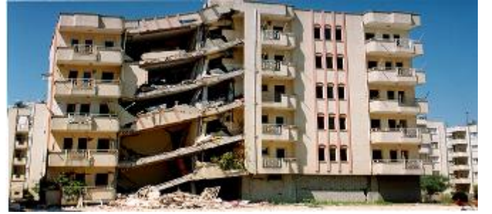
Resim-6: Zemin katı ezilen bina görünümü.
