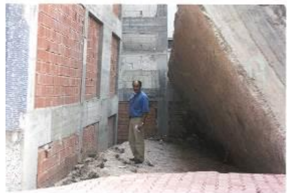
Resim-14: Sığ temel görünümü.
