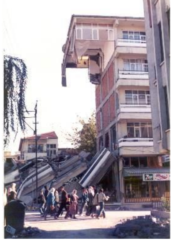
Resim-5: Sol yan cepheye doğru üst katta imal edilmiş kaçak kat görünümü.
