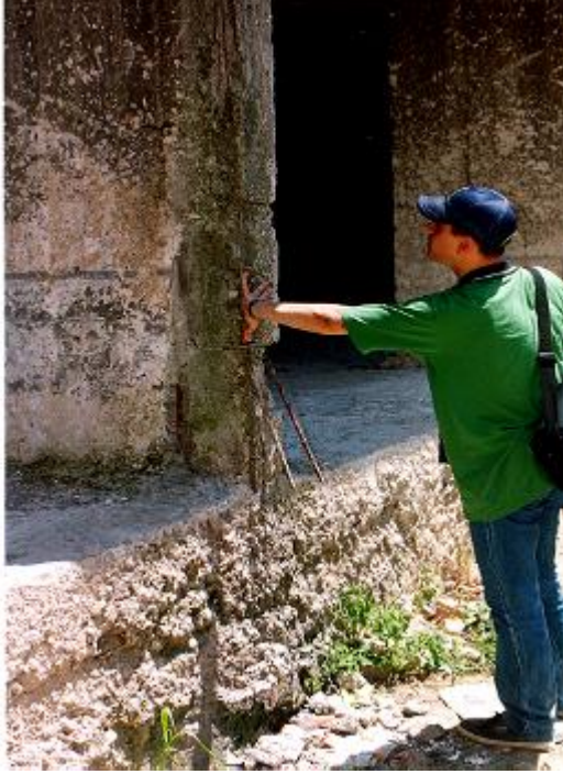
Resim-8: Yetersiz etriye görünümü.
