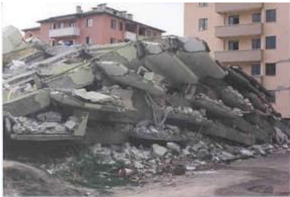
Resim-17: Toptan göçme mekanizmasıyla yıkılmış bina.
