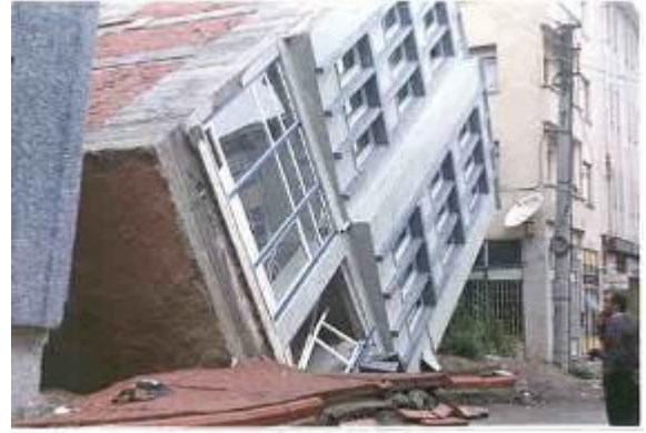
Resim-13: Sığ temel görünümü.
